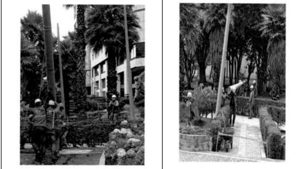
Imagen 6: Postes izados y transportados manualmente.
