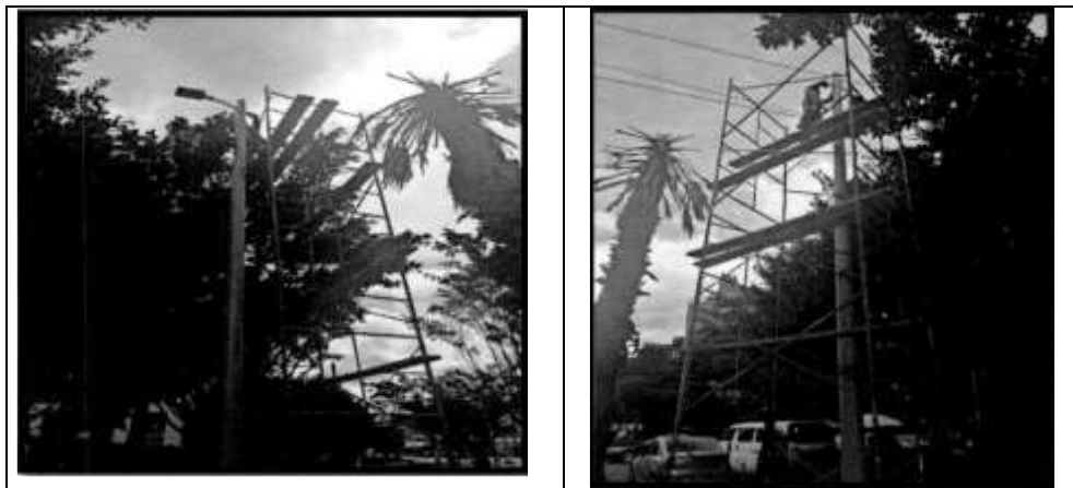
Imagen 7: Instalación de lámparas y brazos manualmente.
