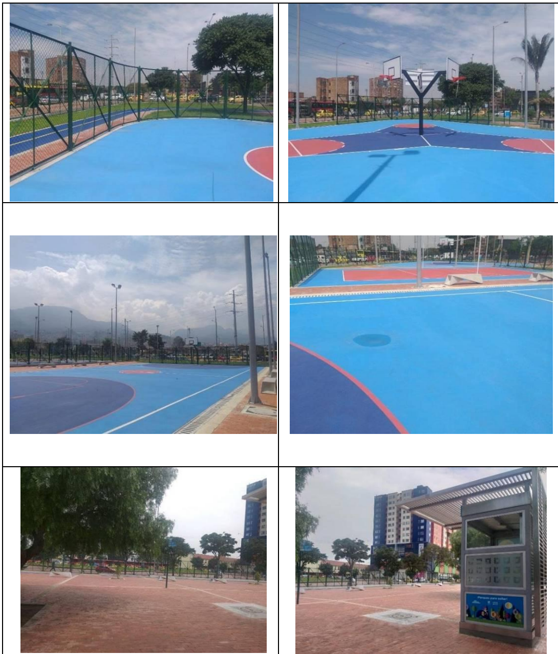
Cerramiento Perimetral y Pórticos de Entrada
